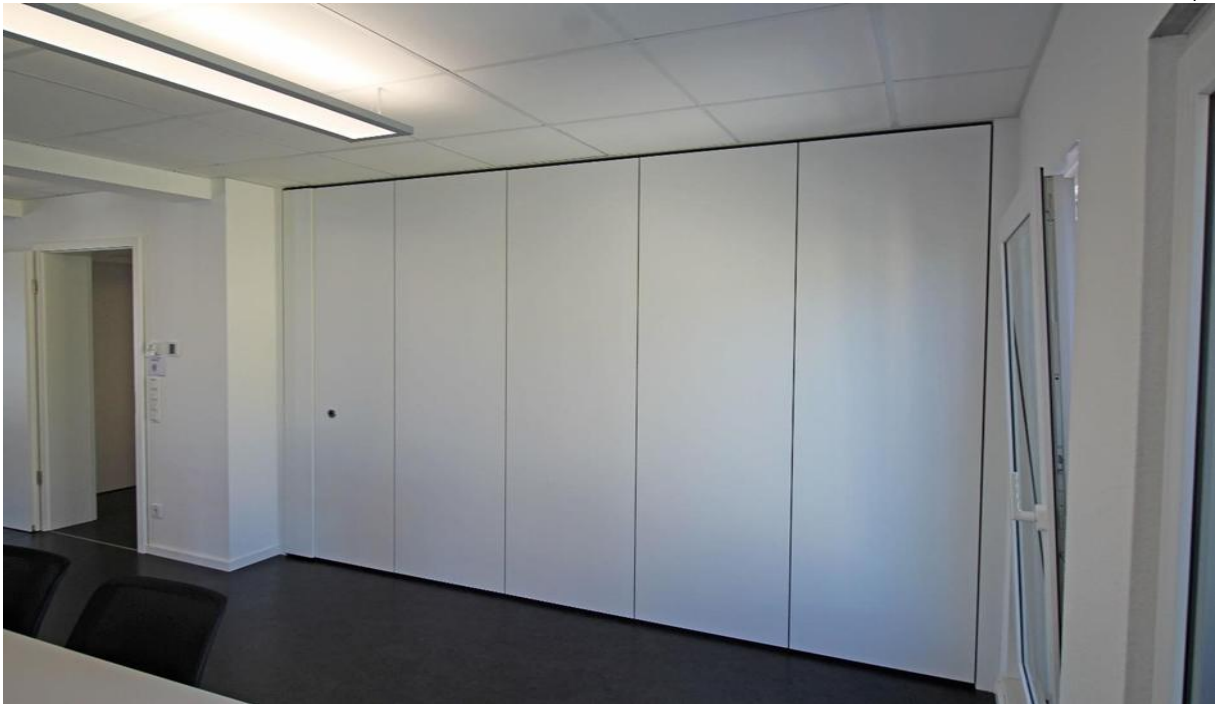
Trennwand zwischen Raum A+B geschlossen
