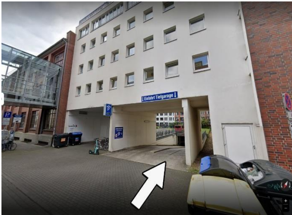
Tiefgarage Am Theater Einfahrt Brunnenstraße:
